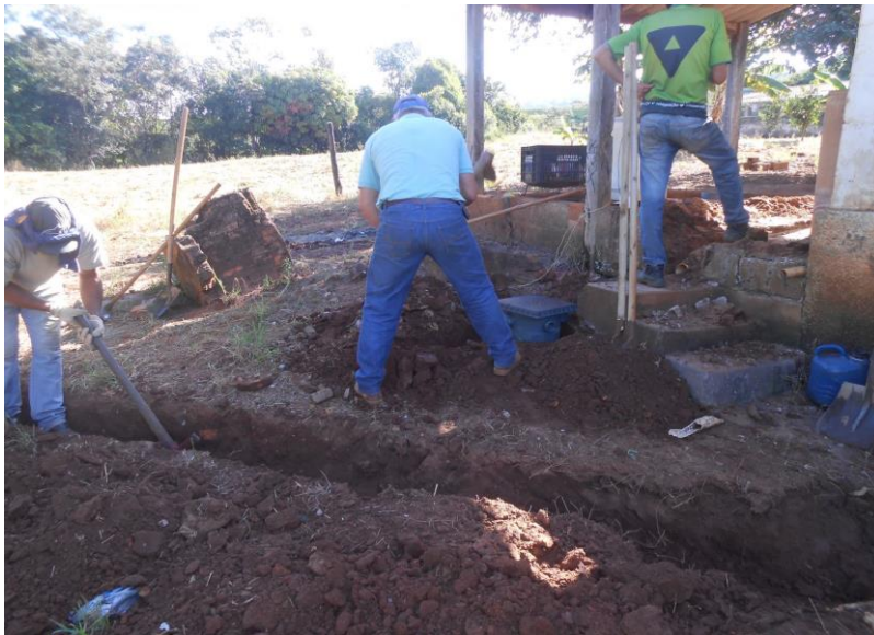
Figura 09: Construção de fossas na comunidade Mercês
